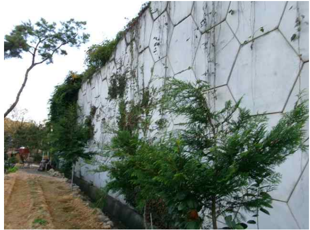
8공구 패널식 옹벽 14
