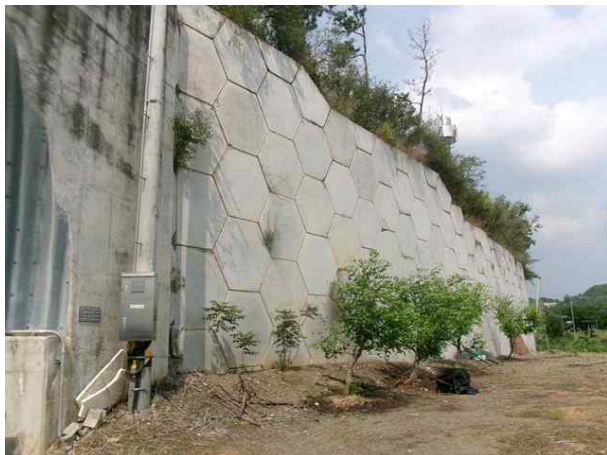
9공구 패널식 옹벽 15
