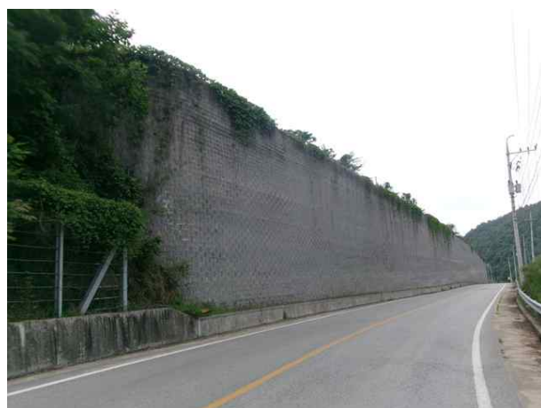
4공구 블럭식 옹벽 04
