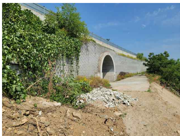
6공구 블럭식 옹벽 09
