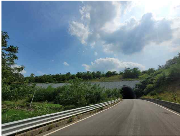
8공구 패널식 옹벽 13
