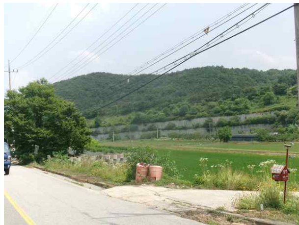
3공구 패널식 옹벽 02
