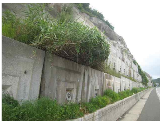
6공구 패널식 옹벽 10
