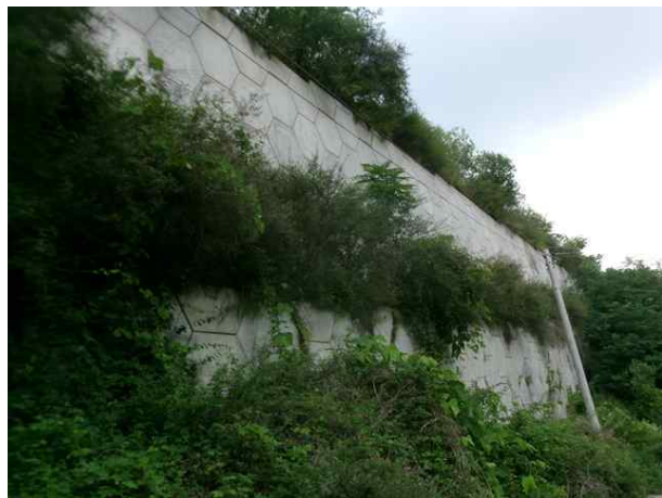
3공구 패널식 옹벽 01
