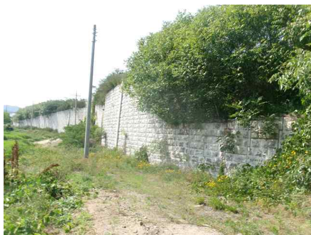
6공구 패널식 옹벽 07
