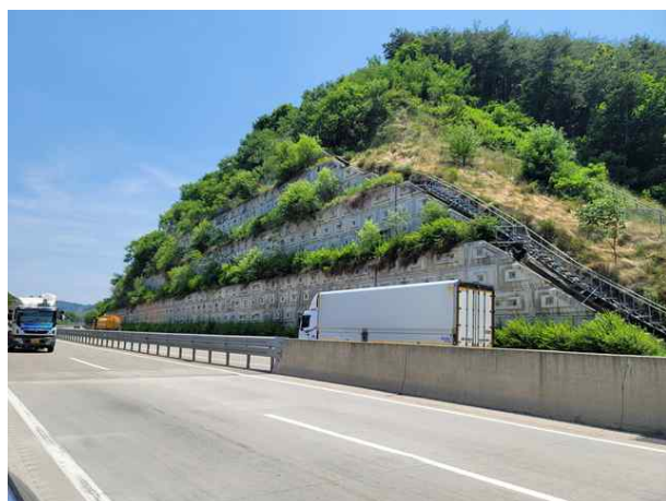
4공구 패널식 옹벽 05
