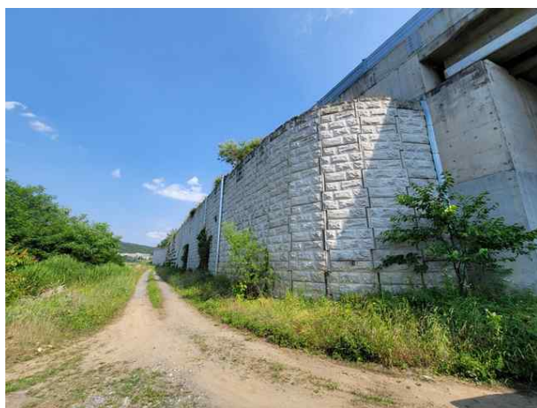
6공구 패널식 옹벽 08
