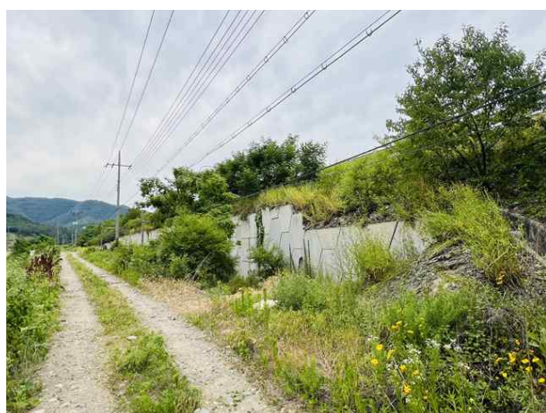
7공구 패널식 옹벽 11
