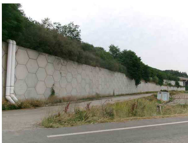
7공구 패널식 옹벽 12
