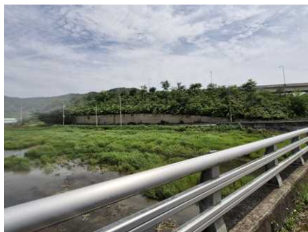
5공구 블럭식 옹벽 06
