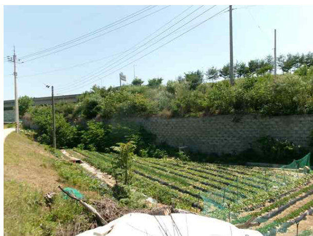
3공구 블럭식 옹벽 03
